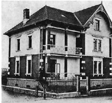
„Villa Bayer“ (Hausnummer 458 1/4 in der Bahnhofstraße 1901).
